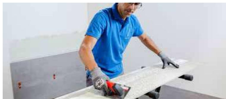
Spread the adhesive cement with a toothed trowel on the tile | Extiende el cemento de agarre con una llanta dentada sobre la pieza | Étendre le ciment à prise rapide à l'aide d'une spatule dentée sur la pièce | Verstreichen Sie den Klebemörtel mit einem Zahnpachtel auf der Fliese
