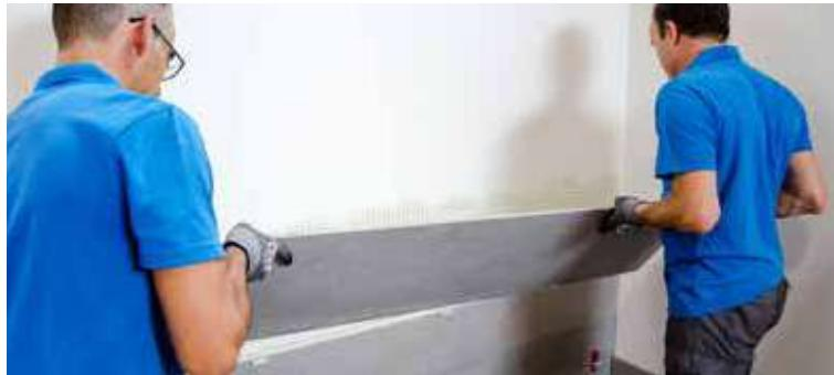
Affix the tile to the pre-prepared surface | Coloca la pieza sobre la superficie preparada | Placer la piece sur la surface préparée | Verlegen Sie die Fliese auf der vorbereiteten Oberfläche
